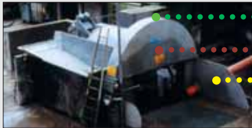
Installation de recyclage du béton
