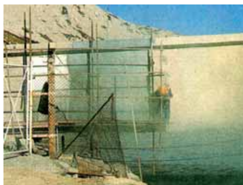
Étanchéification d'un barrage
